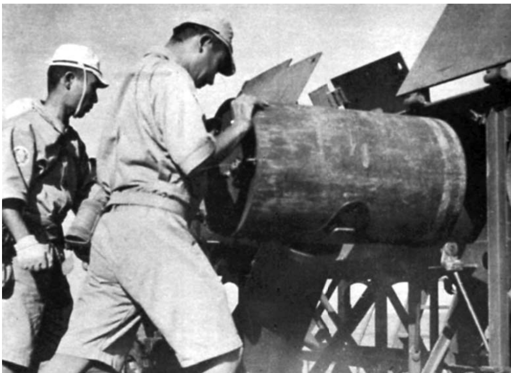
Загрузка бомбы в бомбомёт. Справа виден зарядный стеллаж
